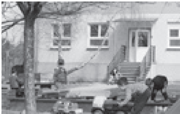
A civil önkormányzat kezdettől fogva sok felújítást, bővítést végzett önerőből a Kacsóh P. utcai óvodaépületen, rövidesen pedig teljesen megszépül az újtelepi óvoda.
